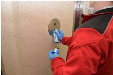
エレベーターボタン 塗布施工イメージ
