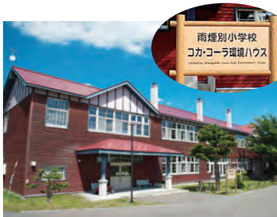
雨煙別小学校 コカ・コーラ環境ハウス
