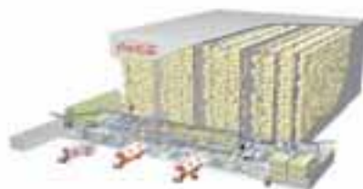
製品を自動で出入庫する高さ31mの立体自動倉庫の内部を見学することができます
